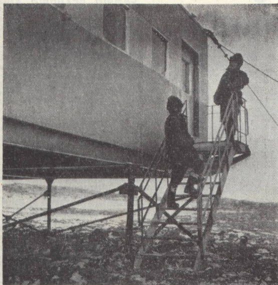
А это станция Молодежная. Морозы и страшные ветры предъявляют строгие требования к строителям. И вот созданы новые, удобные и прочные домики из готовых плит.
